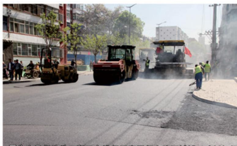
图为上马街改造工程正在进行沥青混凝土路面摊铺 武树桐摄
